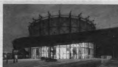
Konverze plynojemu na multifunkční halu Gong, Ostrava-Vítkovice, architekt Josef Pleskot 2012
