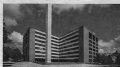
Nová budova Fakulty architektury ČVUT, Praha, architekti Alena Šrámková a Tomáš Koumar Lukáš Ehl, 2011
