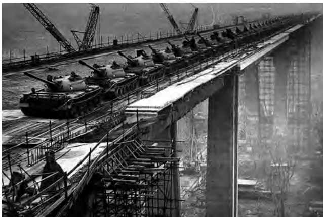
Při statické zkoušce v listopadu 1970 zatížilo Nuselský most 66 tanků, které do Prahy přijely z rakovnického pluku
